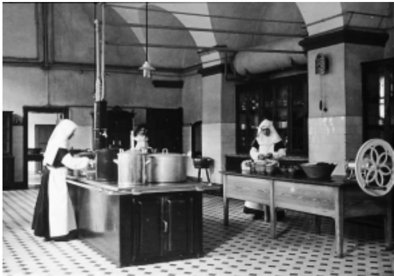
Eine der ersten Aufnahmen zu Beginn des vorigen Jahrhunderts gewährt einen Blick in die Klosterküche. Heute ist sie viel moderner ausgestattet.
